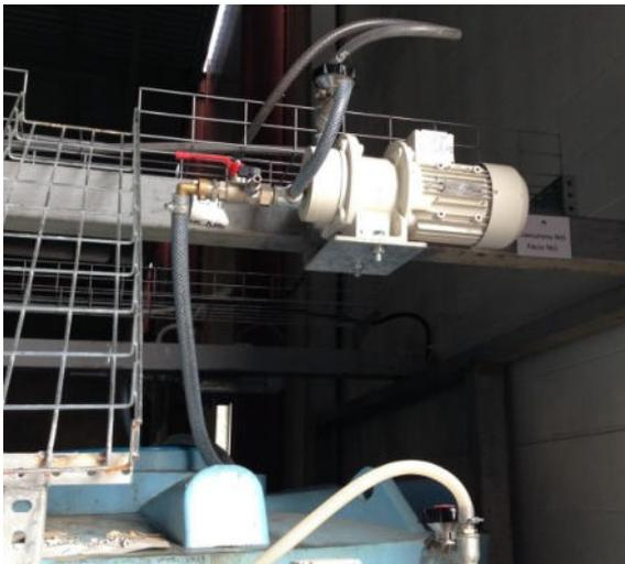
Unterschiedliche Einbausituationen als Füllpumpe
