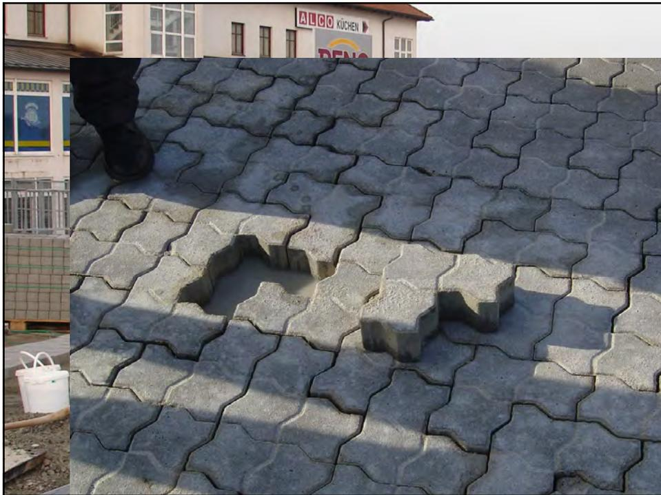
*Die Herstellung von Pflasterdecken und Plattenbelägen setzt voraus, dass die Unterlage geeignet ist; insbesondere muss sie ausreichend tragfähig, wasserdurchlässig sowie profilgerecht und eben sein. Entsprechende Prüfungen sind **Besondere Leistungen**, sofern sie vom Auftragnehmer durchzuführen sind.*
