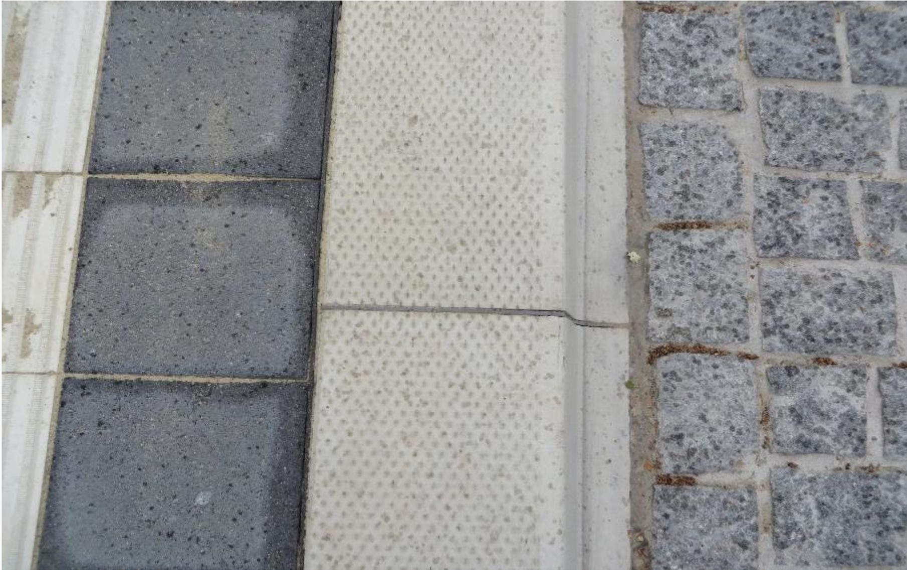
Bewegungsfugen: aus Polyolefin (vernetzter PO-Schaumstoff)
