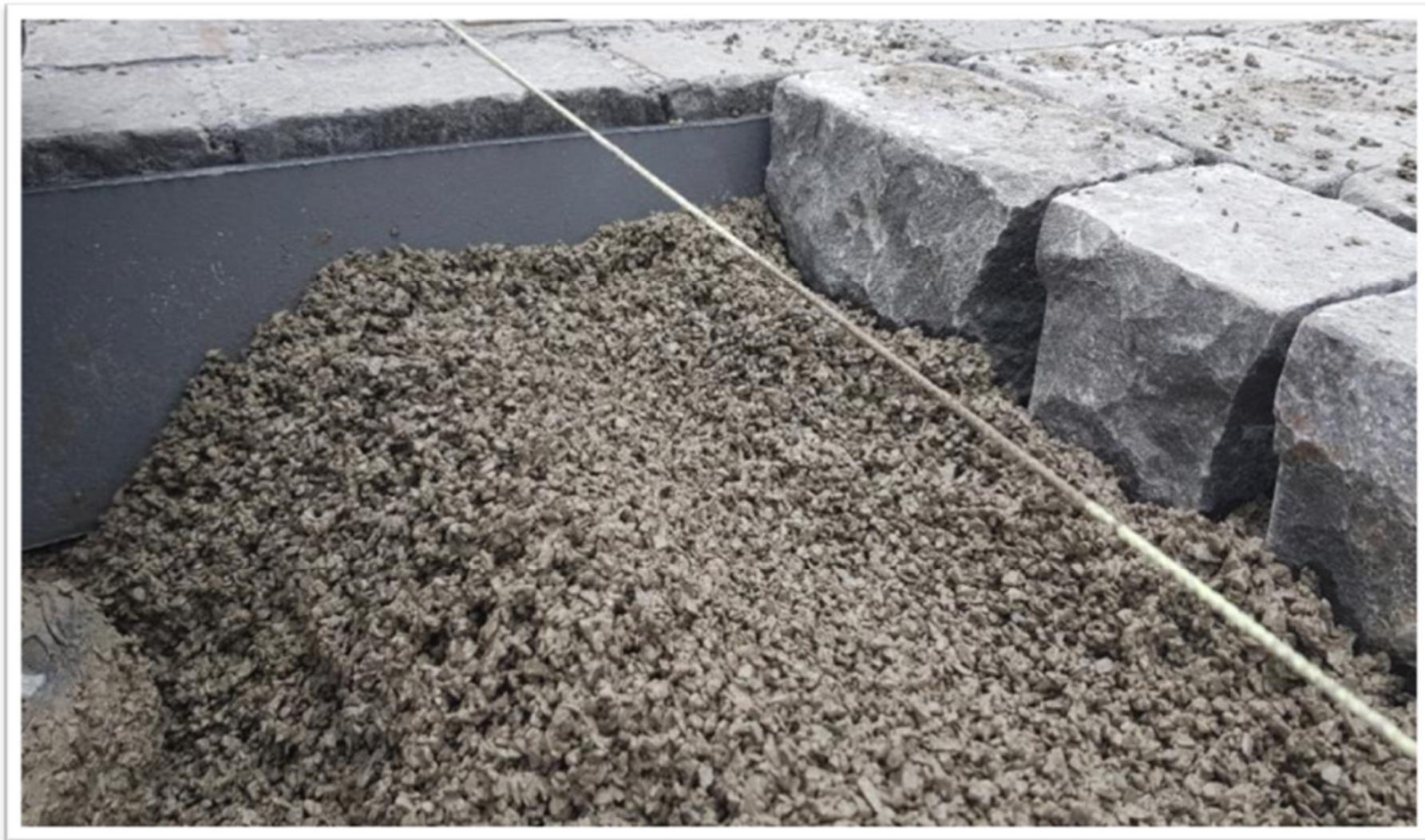
Bewegungsfugen: aus Polyolefin (vernetzter PO-Schaumstoff)
